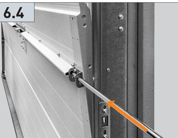
Ru      В случае ограниченного бокового пространства установка тяг замка производится на снятой панели
