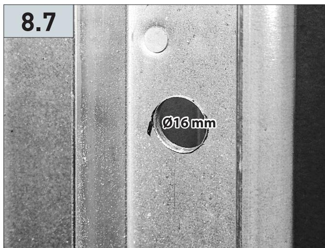
Ru      Поднимите полотно и просверлите отверстие Ø16 мм
