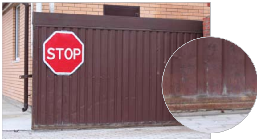
Сдвижные ворота из профлиста с открытой верхней балкой, корродирующие сварные соединения
