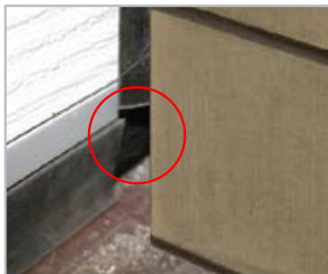
Отсутствие уплотнителя в нижнем угловом стыке ворот Компании 3
