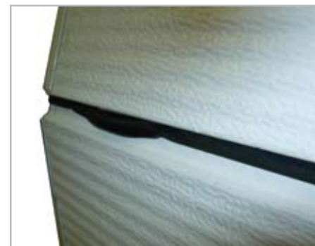
Плохо закрепленный уплотнитель Компании 3
