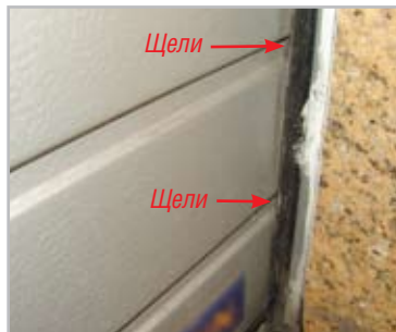
Плохо прилегающий уплотнитель Компании 2
