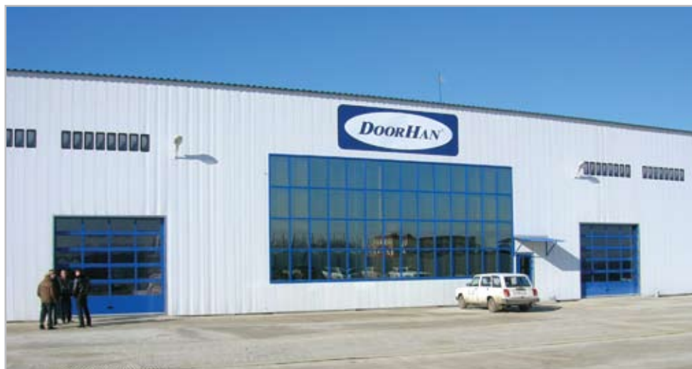
Производственно-складское помещение в Ростове-на-Дону, построенное DoorHan
