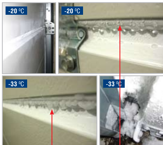
Образование ледяной корки на стыках
