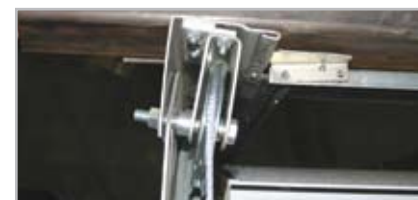
Перекос натяжного ролика промышленных ворот Компании 3 с задним расположением торсионного механизма
