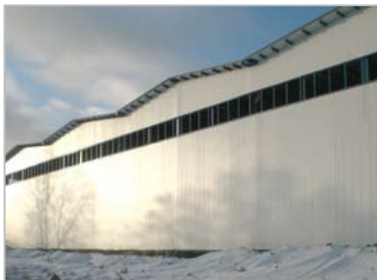
Строящееся представительство в Екатеринбурге
