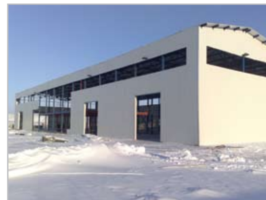
Строящееся представительство в Красноярске
