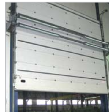
Промышленные ворота DoorHan с выносным монтажом системы октагональных валов
