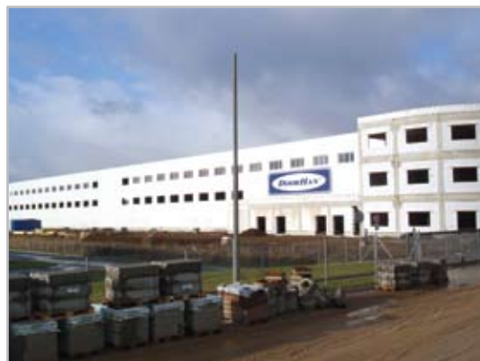
Строящийся завод в Кадани, Чехия
