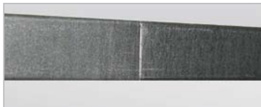
Стык боковых крышек на полотне ворот DoorHan полностью закрывает пенный уплотнитель от проникновения влаги
